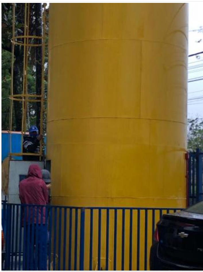
Manutenção da parte elétrica da caixa d'água 28-07-2021
