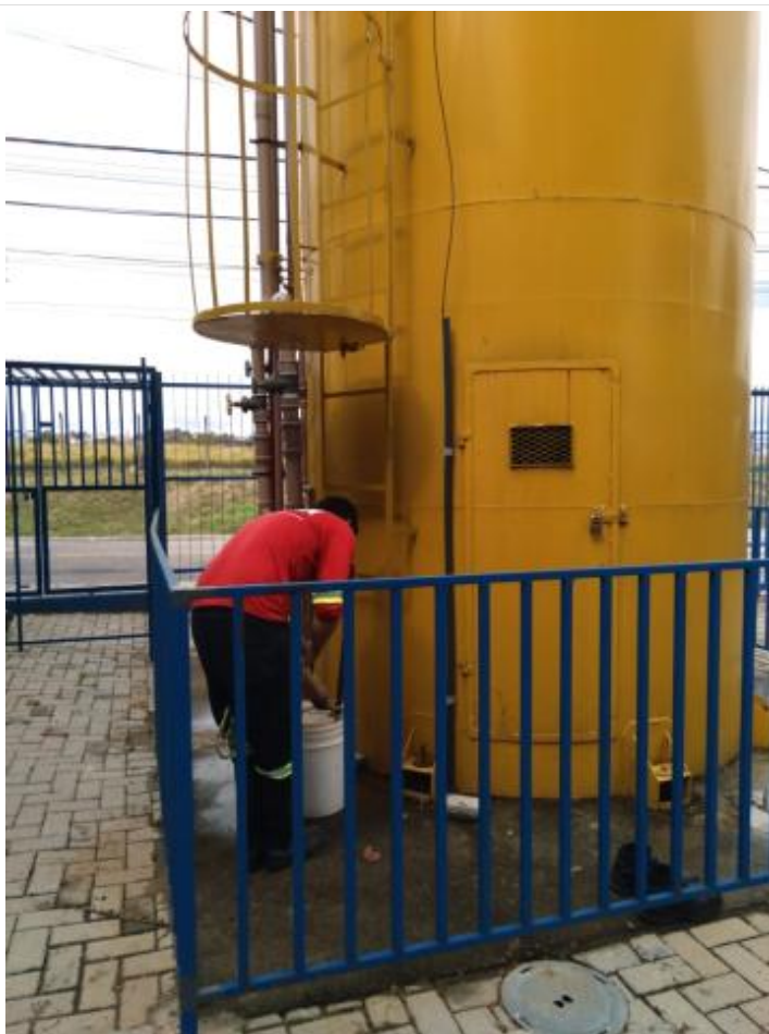
Limpeza da caixa d'água 06-07-2021 (3)
