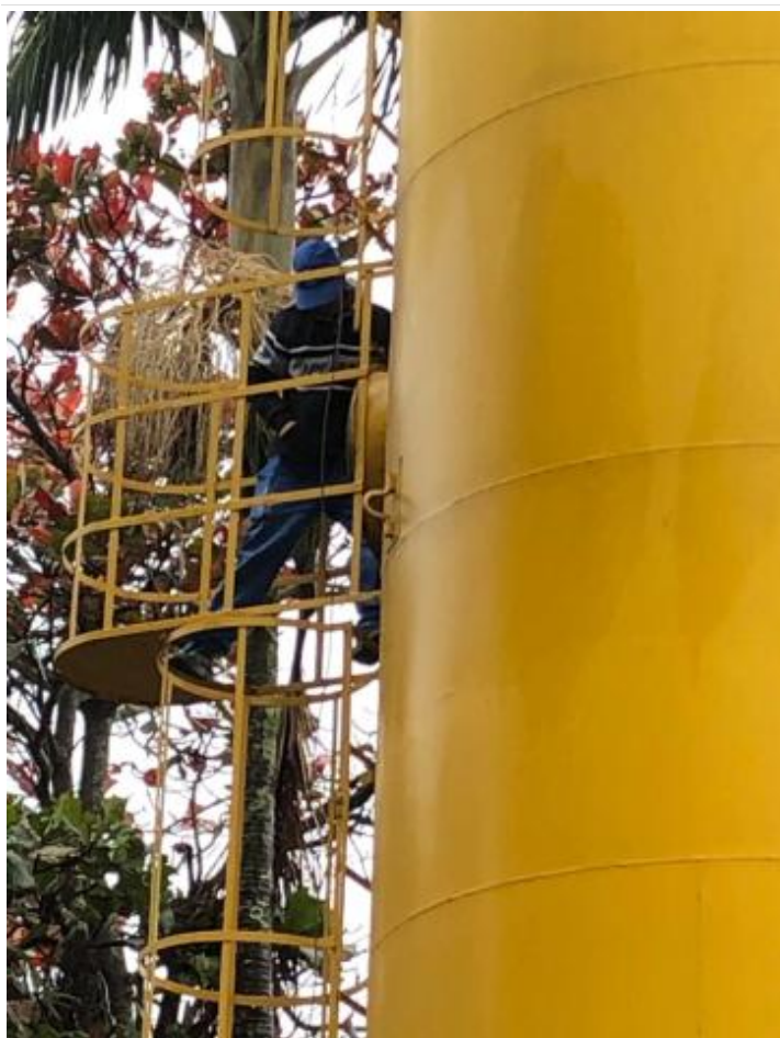
Manutenção na parte hidráulica da caixa d'água 28-07-2021
