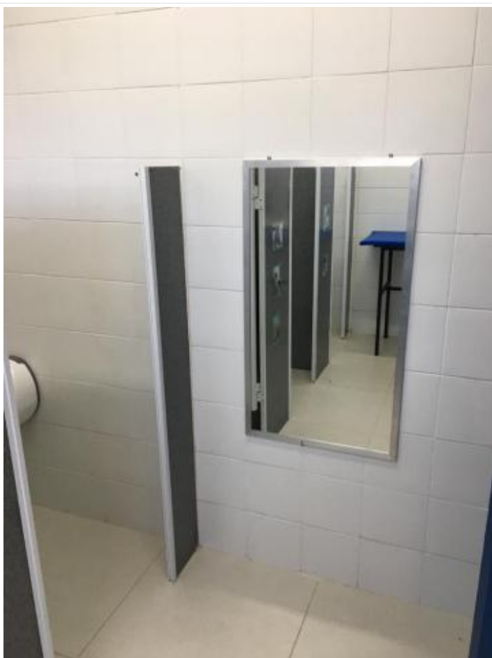
Instalação de espelho nos banheiros infantis 22-07-2021 (1)
