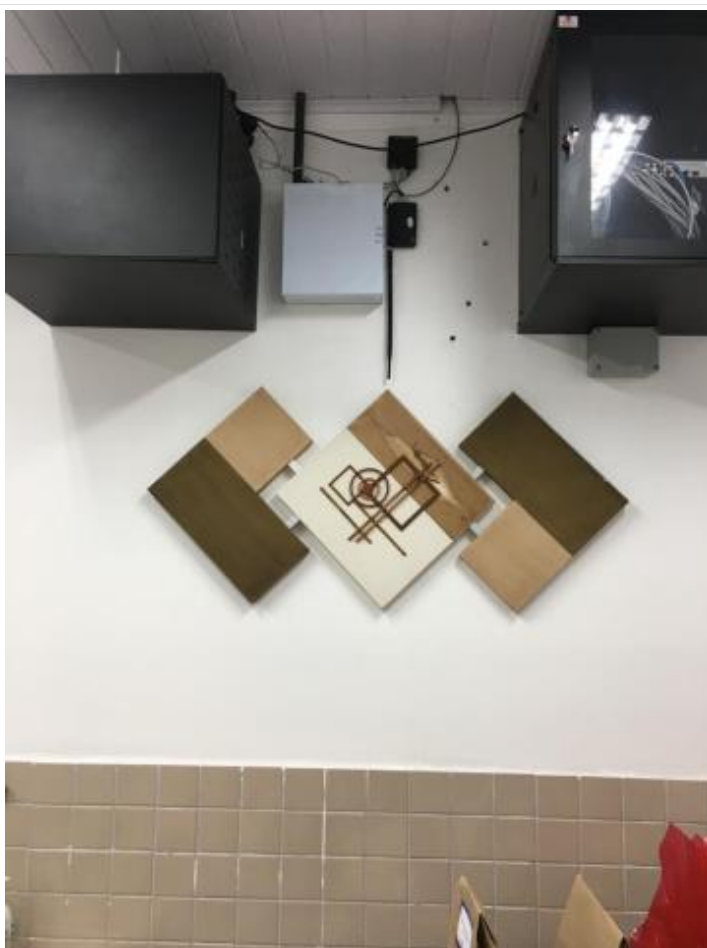
Instalação de quadro na sala da Direção 16-07-2021
