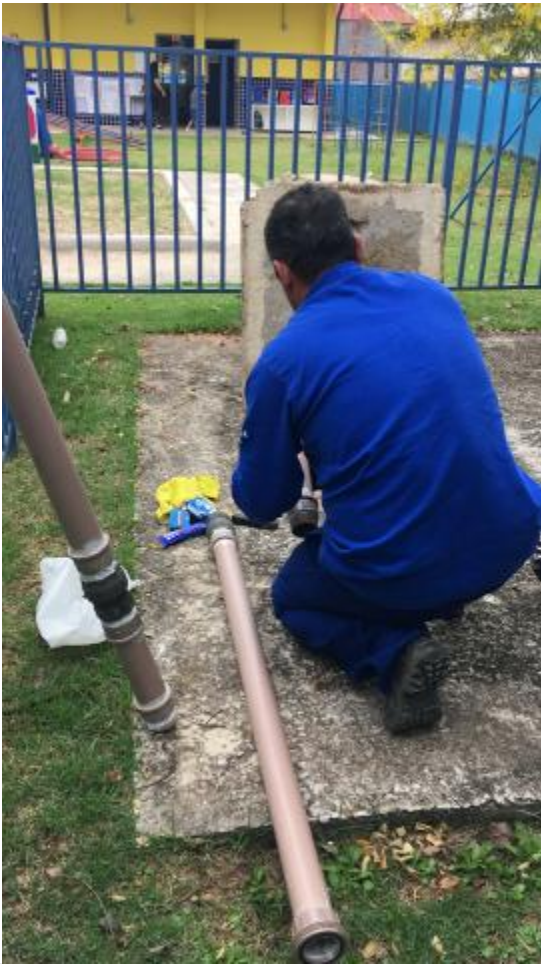
Reinstalação da bomba pluvial 06-12-2021
