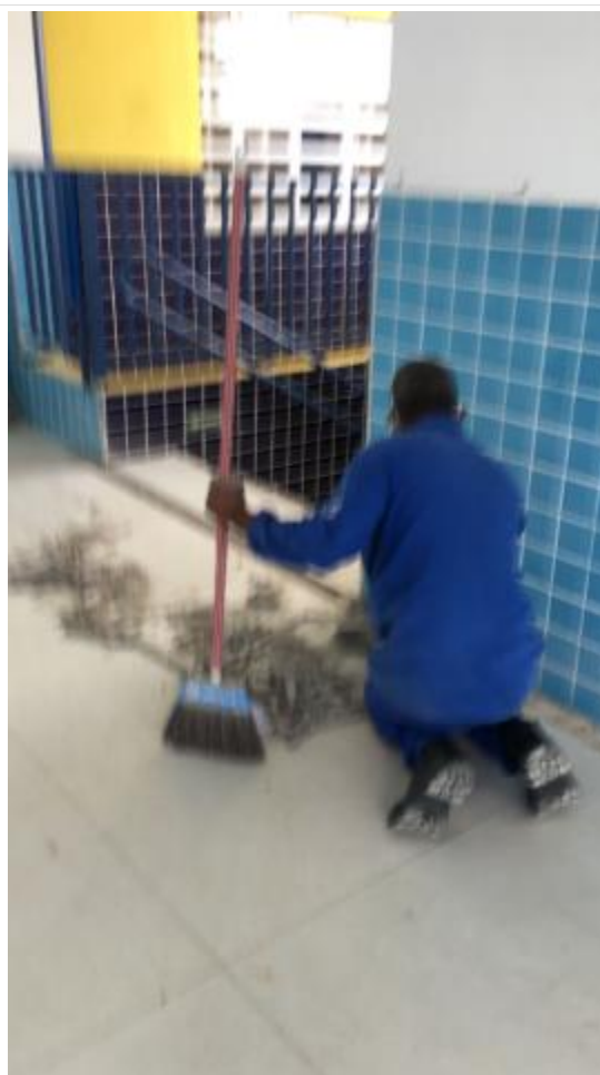
Retirada do trilho do portão do pátio 08-12-2021
