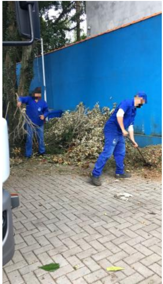
Retirada do mato da capina e da poda 18-11-2021
