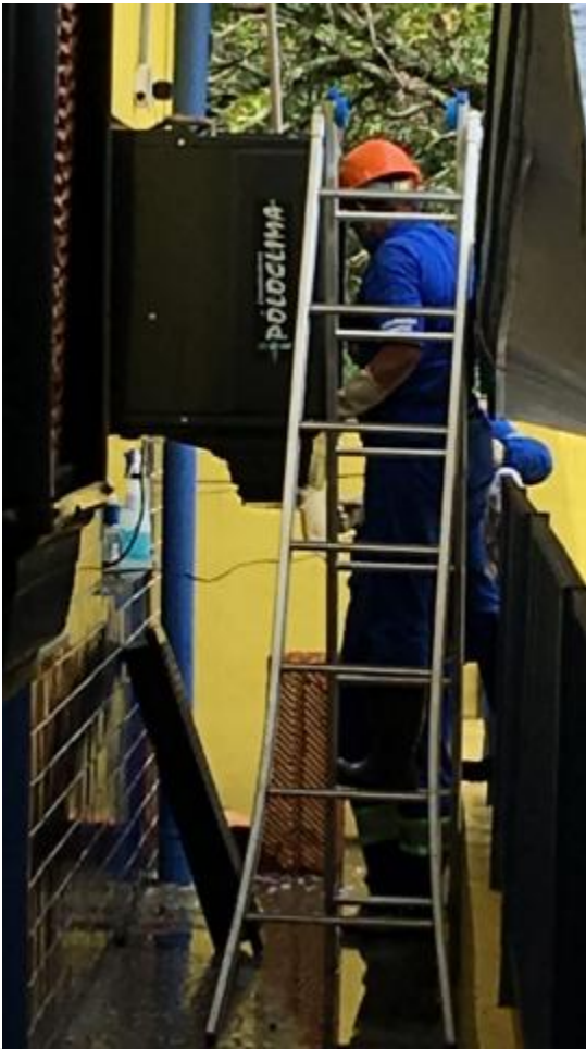
Limpeza dos climatizadores 19-11-2021
