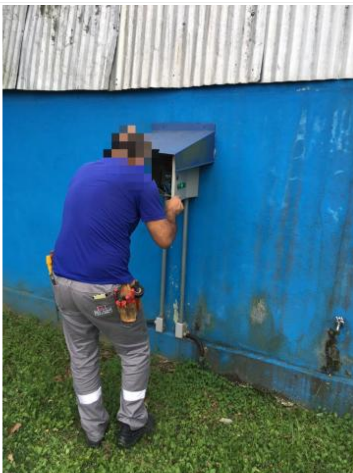
Manutenção na Bomba 11-11-2021 (1)
