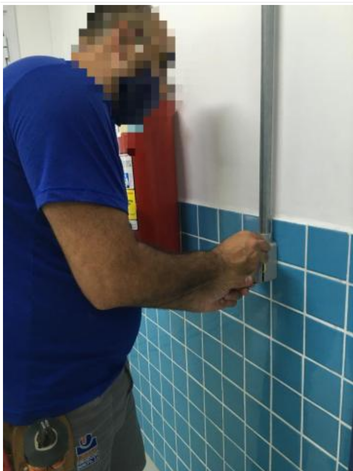
Manutenção parte elétrica 10-11-2021 (1)
