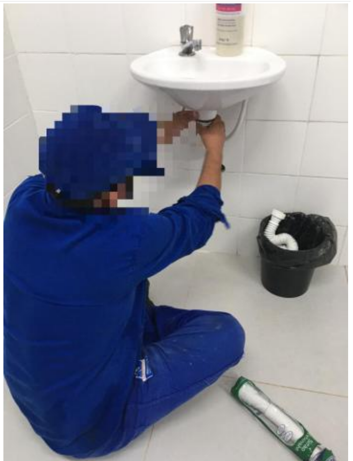
Troca do sifão do banheiro 11-11-2021
